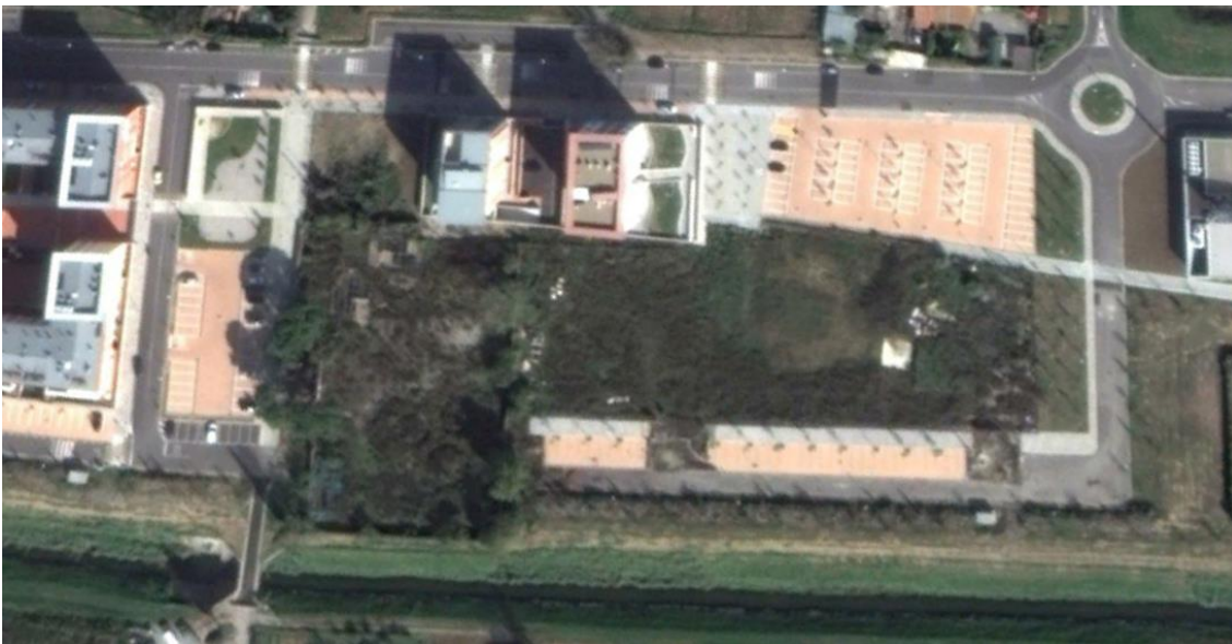
Fig. 6 – Vista aerea del terreno oggetto di stima risalente al 2012
